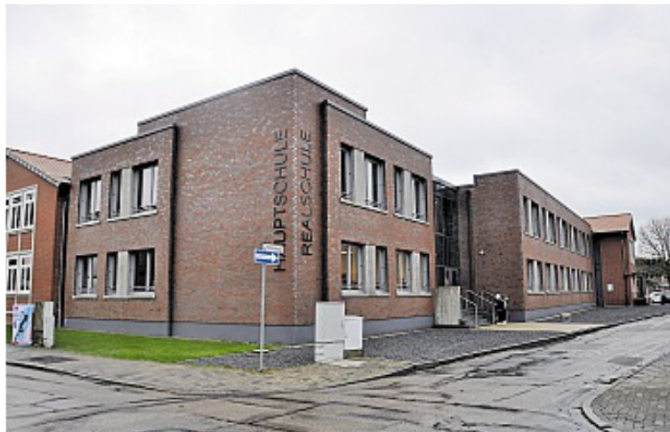
Erst Ende 2020 ist der Anbau an der Heinrichstraße bezogen worden. Nun gibt es erneut Erweiterungsbedarf.
