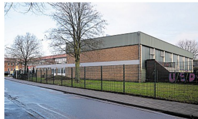
Die Turnhalle an der Heinrichstraße könnte abgerissen werden.
